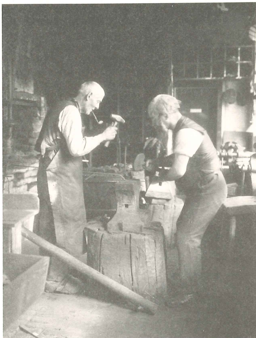
M 5.1 Innenansicht einer Handschmiede (Gebrüder Hartkopf in Solingen-Scharfhausen). Links der sog. Darhalter, rechts der sog. Affhauer. (Foto: Stadtarchiv Solingen)
